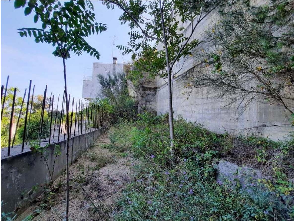
Foto: espai entre estructures existents. Mur que es manté dret i contenció del que havia de ser planta soterrani de l'edificació
