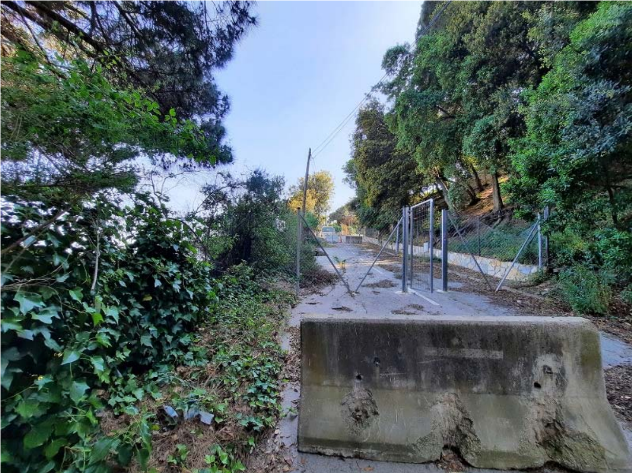
Foto: tanques provisionals per evitar el pas a la zona de perill
