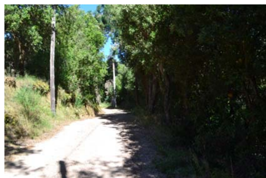
Figura 6. Capa de rodadura de tot-ú
