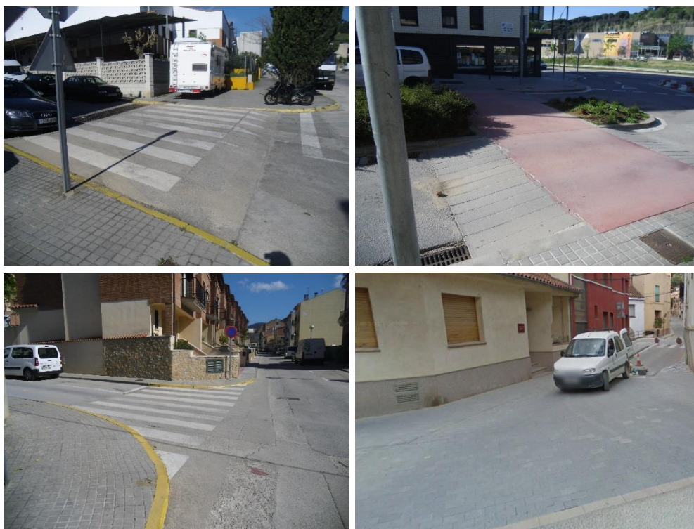
Imatge 14: Exemples de passos de vianants elevats (fotos superiors), normal (foto inferior esquerra) i vorera contínua (foto inferior dreta) (Font: EMU Arenys de Munt)
