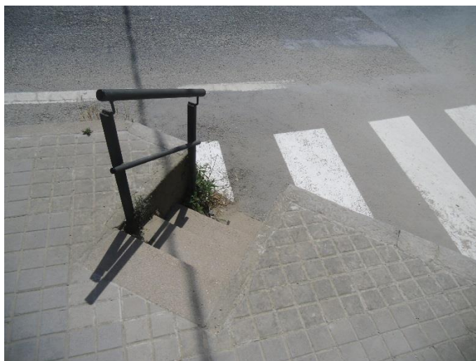
Imatge 9: Exemple de discontinuïtat de vorera al passatge de la Cotxeria amb ctra. de Sant Celoni(Font: EMU Arenys de Munt)
