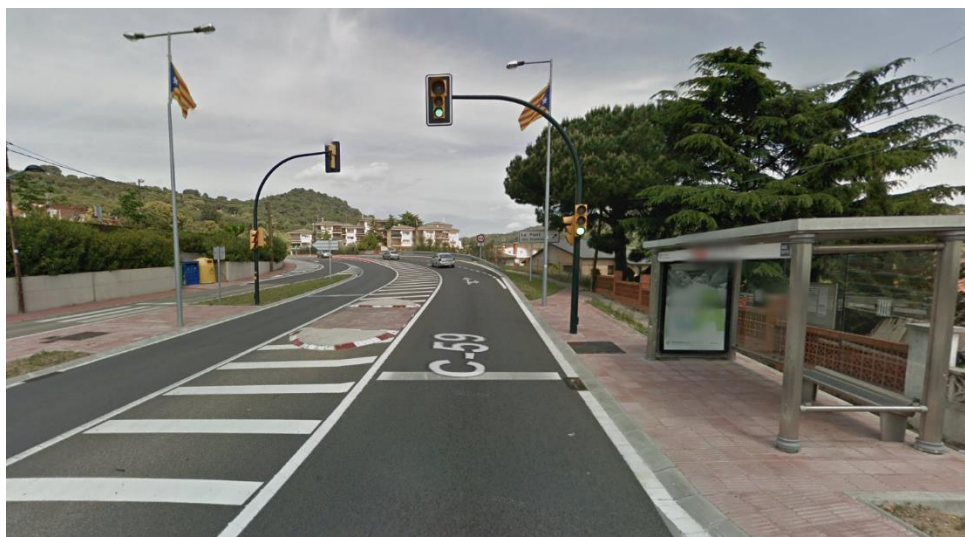
Imatge 67: Carretera C-59. Municipi: Urbanització els Saulons. Caldes de Montbui (IMD de la via: 11.105 PK 16,64)
