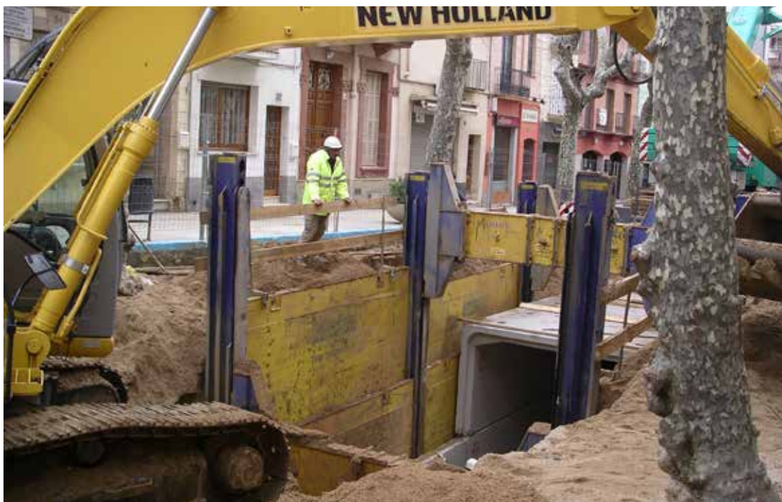
Obres de soterrament de la Riera (1) i (2)
