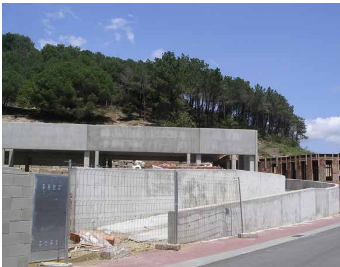
Construcció de l'escola bressol
