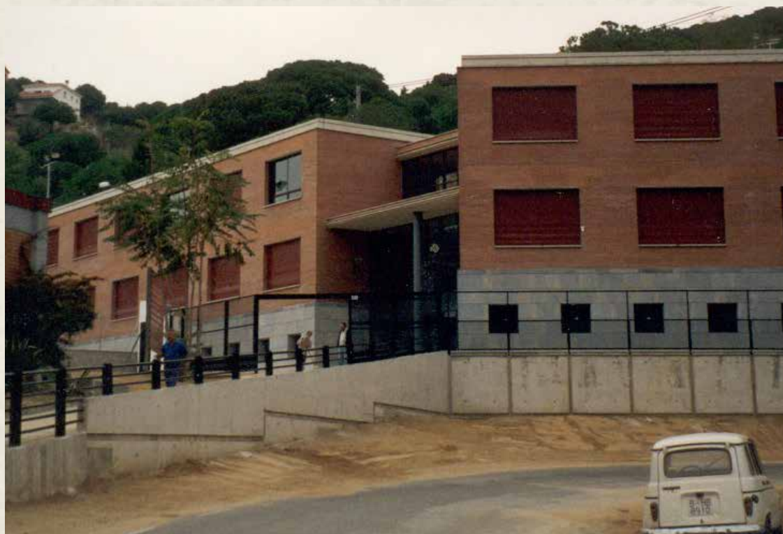
Ampliació de l'Institut Domènec Perramon
