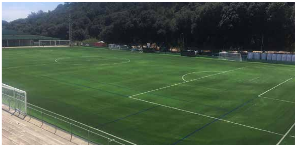
Instal·lació de gespa artificial al camp de futbol
