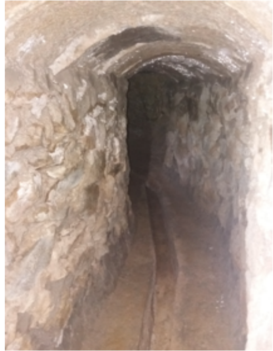
Tram principal amb canalització
