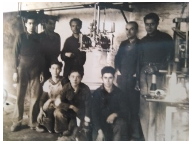
Treballadors de Can Josep Colomer
