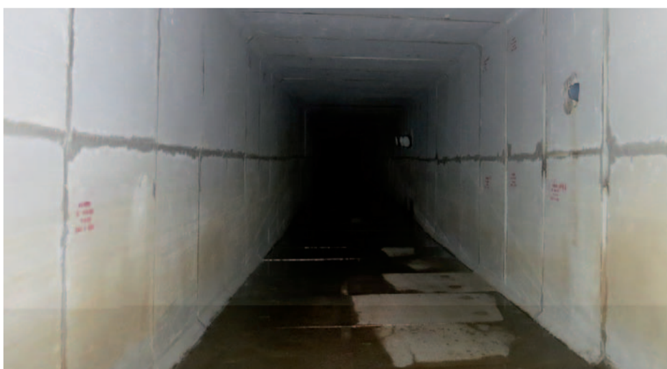
Foto d'un tram dels calaixos de la canalització de la Riera
